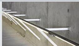
Als zusätzliche Hilfe werden Handläufe an den Fluchtwegen angebracht. Sie befinden sich auf einer Höhe von etwa einem Meter und sind beleuchtet.
