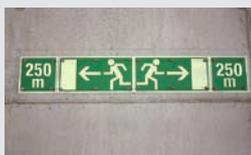
Piktogramme und Richtungspfeile weisen zum nächstgelegenen sicheren Bereich. Die maximale Entfernung beträgt 250 Meter.
