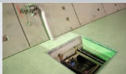
Alle 125 Meter sind Löschwasserentnahmestellen im Tunnel angebracht. Sie können mit 800 Liter Wasser pro Minute versorgt werden.
